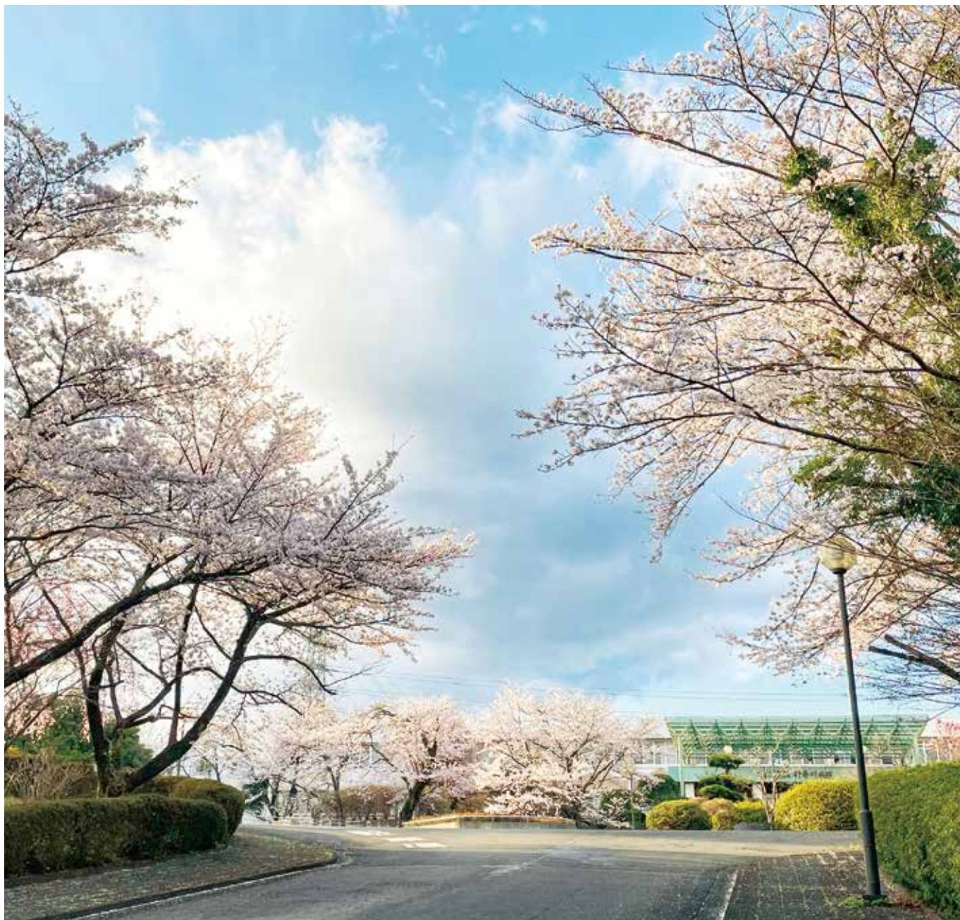
神奈川病院正面より
